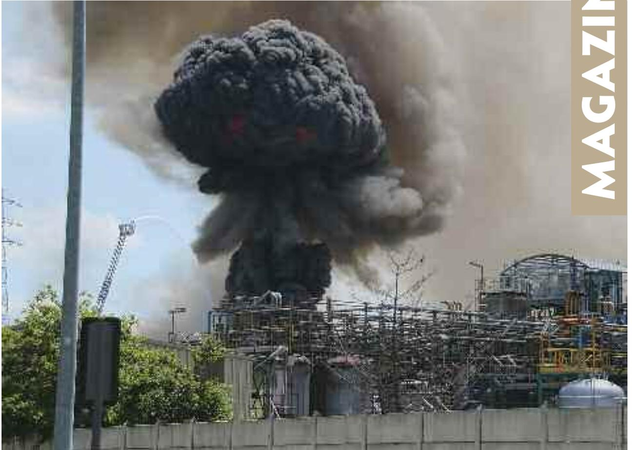
des fûts de 200 litres et des citernes plastiques de 1 m<sup>3</sup> situés en plein air entre les deux. La première lanceca- non est mise en oeuvre entre ces deux zones pour l'éviter. Dans le même temps, le feu se propage par rayonnement à la toiture d'un entrepôt d'une entreprise voisine.
